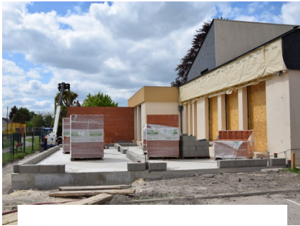
Travaux d'agrandissement de la mairie
