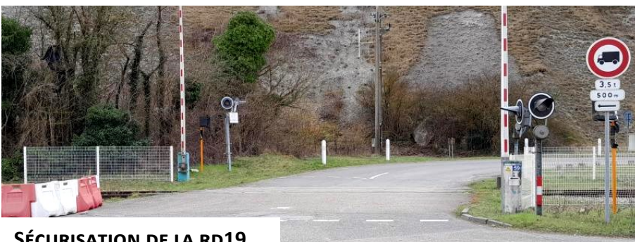
SÉCURISATION DE LA RD19
