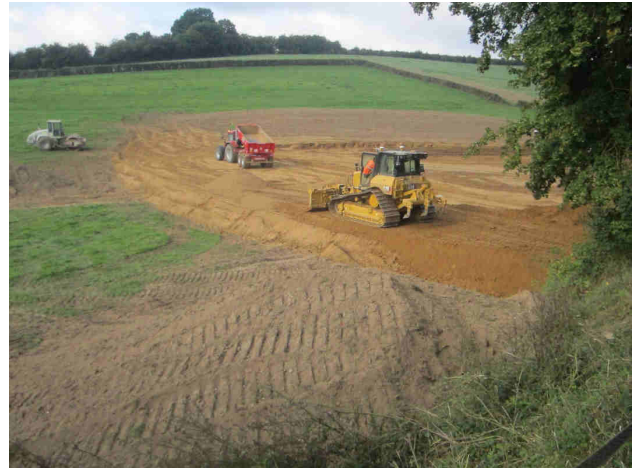
Mise en place du barrage par remblaiement par couches de limons traitées à la chaux et compactées tous les 20 à 30cm
