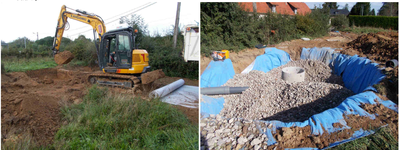
Figure 12: travaux de création d'une zone d'infiltration
