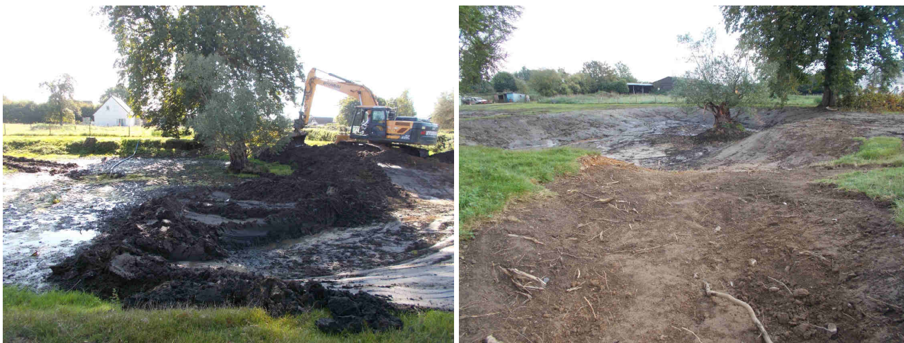
Figure 4: photos avant et après les travaux de réhabilitation de la mare de Perruel
