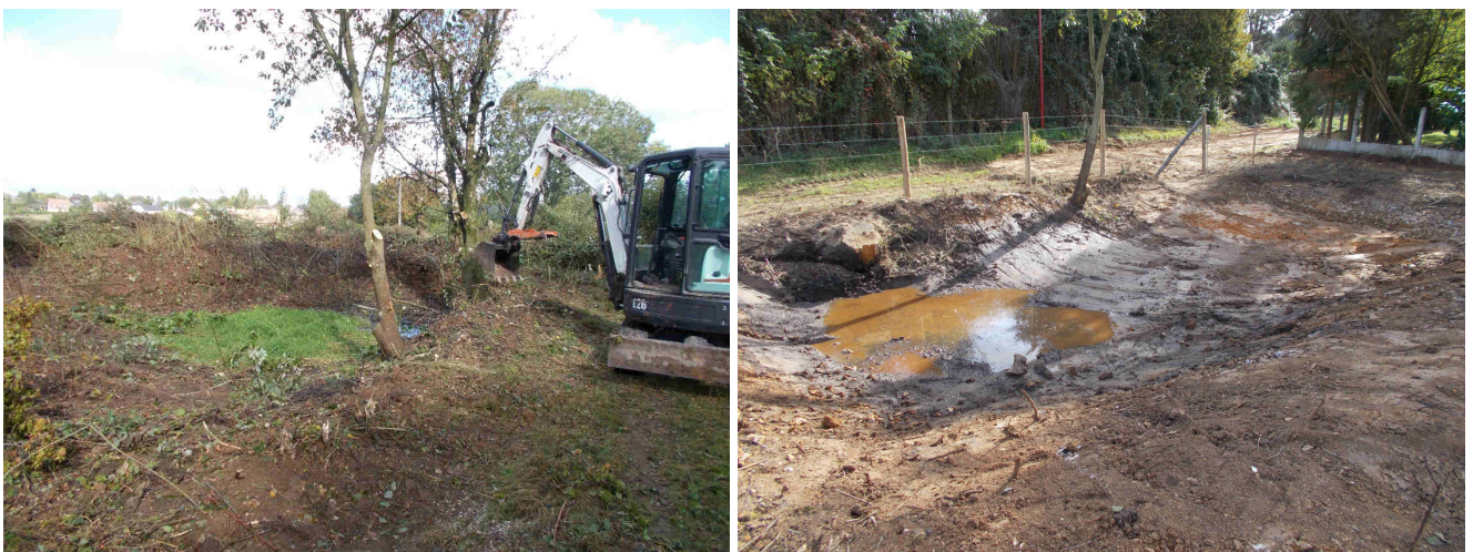
Figure 10: photos des travaux de réhabilitation de la mare
