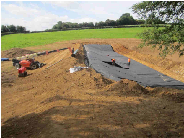
Mise en place du complexe d'étanchéité et remise en place définitive de la terre végétale
