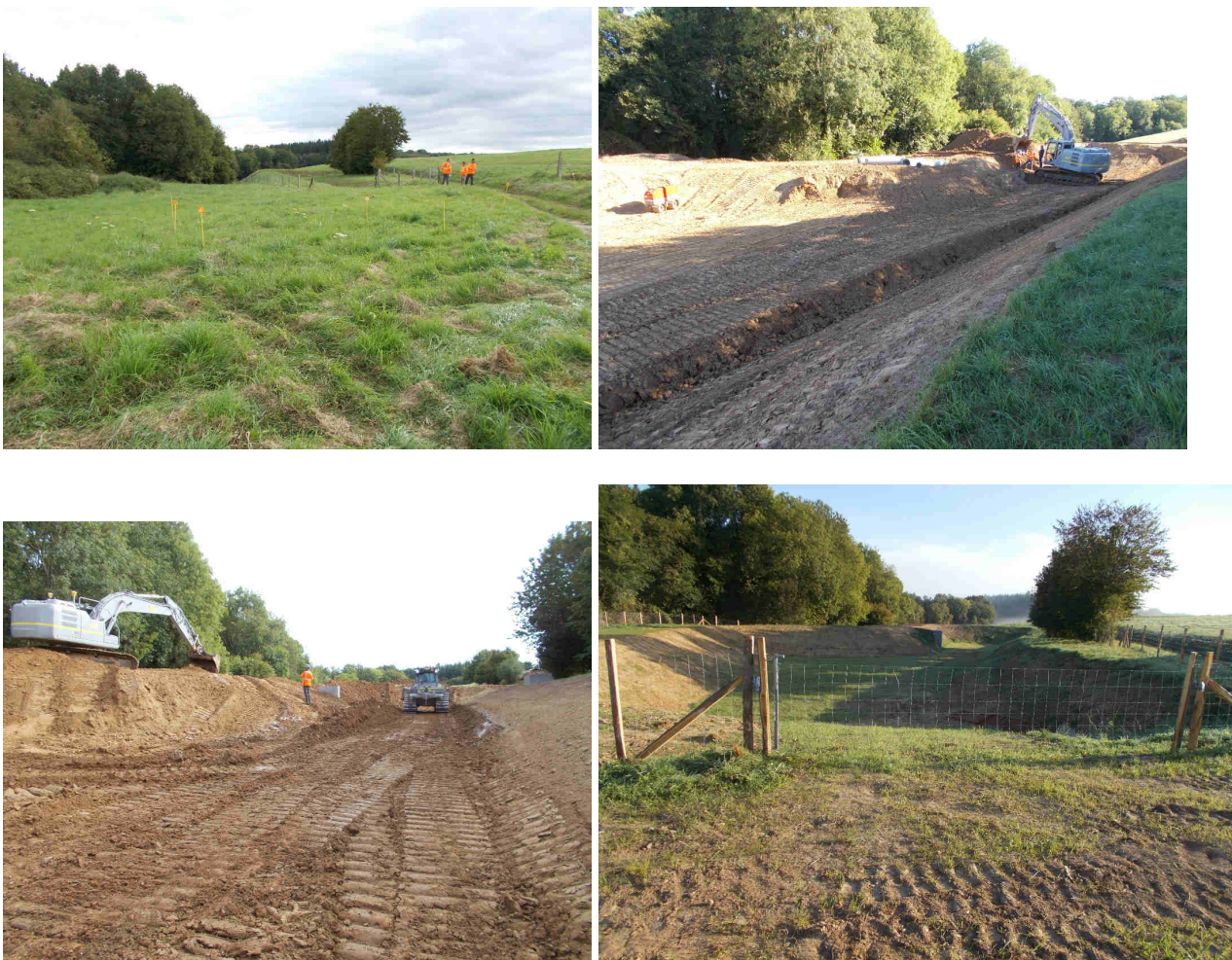
Figure 17: photos du début du chantier jusqu'à l'installation du débit de fuite, finalisation des terrassements et installation des clôtures
