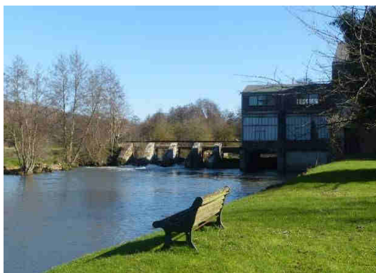
Vue aval de l'ouvrage avant travaux
