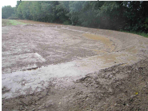
Mare tampon en amont du secteur du cimetière de Saint-Germain-des-Essourts
