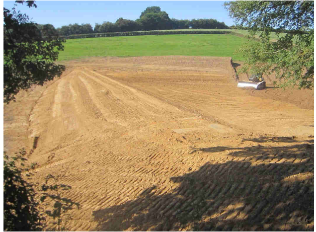
Remblais terminé et remise partielle de la terre végétale
