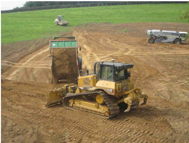
Mise en place du barrage par remblaiement par couches de limons traitées à la chaux et compactées tous les 20 à 30cm
