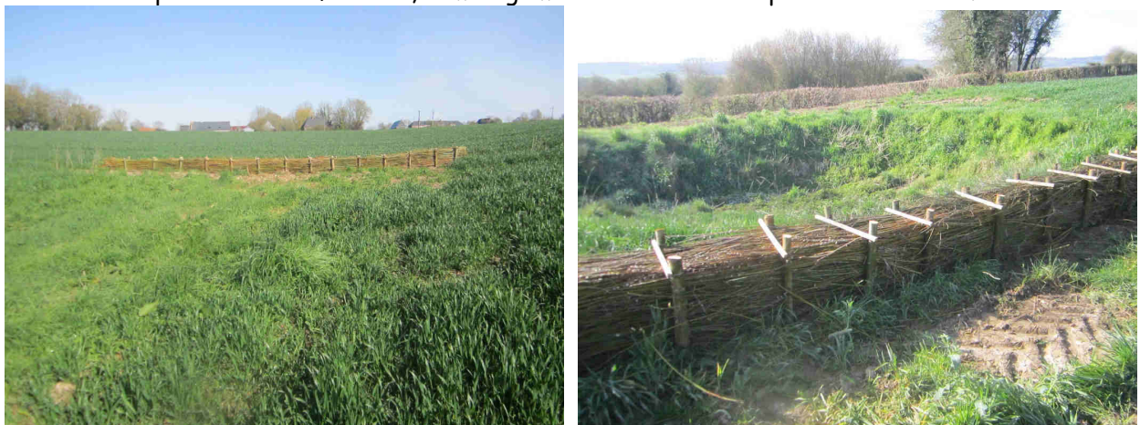
Mise en place de deux fascines en amont de la RD128 (Route de Fry à Mésangueville)
