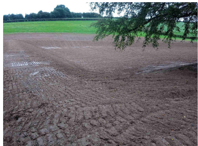
Mise en place du complexe d'étanchéité et remise en place définitive de la terre végétale
