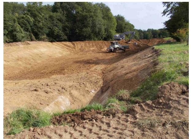
Réhabilitation et agrandissement d'un ouvrage hydraulique de type barrage enherbé à Val d'Orger
