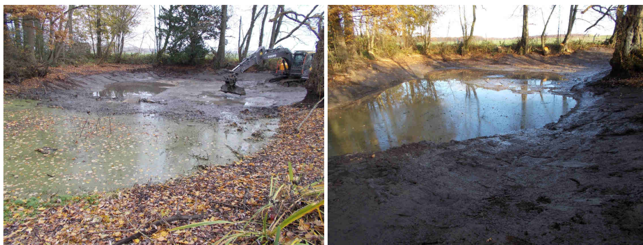
Figure 2 : photos durant et après les travaux de réhabilitation de la mare en janvier 2023
