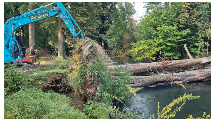
Enlèvement d'embâcles à Pont Saint Pierre
