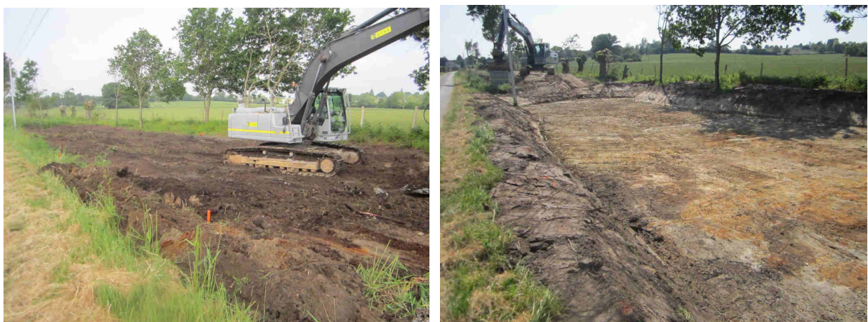
Création d'une mare tampon (Rue Manoir des Mares - commune de Mésangueville)
