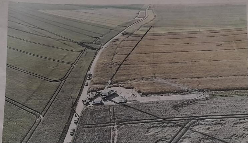
Dans les champs de Flipou, un pylône de 48 m a été installé, jeudi 19 juin 2025, pour le déploiement du réseau téléphonique mobile. Photo Julien Jacq
