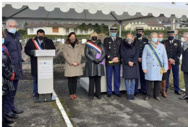
Conseillers départementaux, députée, sénateurs et élus locaux se sont déplacés pour la pose de la première pierre.
